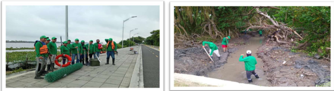
Limpieza y cambio de malla de box coulvert – la playa
