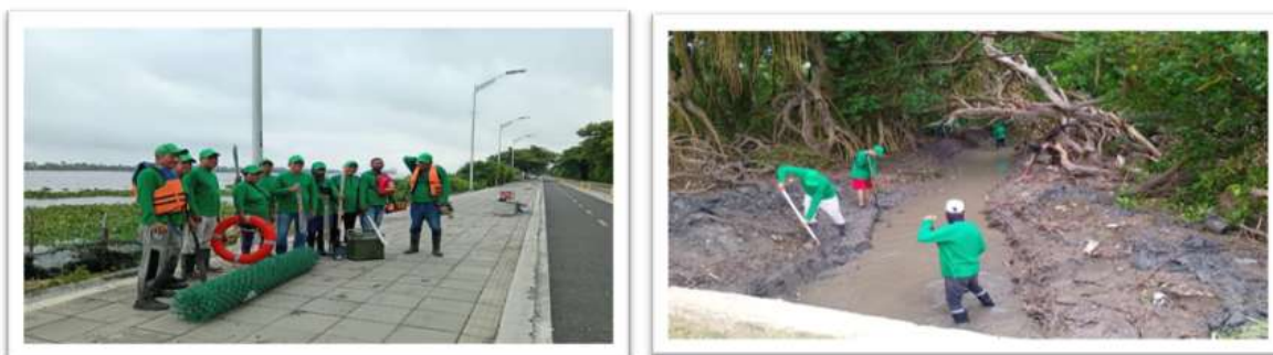
Limpieza y cambio de malla de box coulvert – la playa
