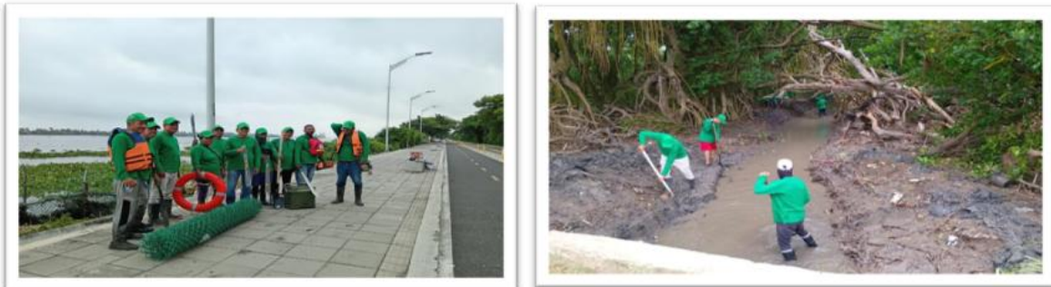
Limpeza y cambio de malla de box coulvert – la playa
