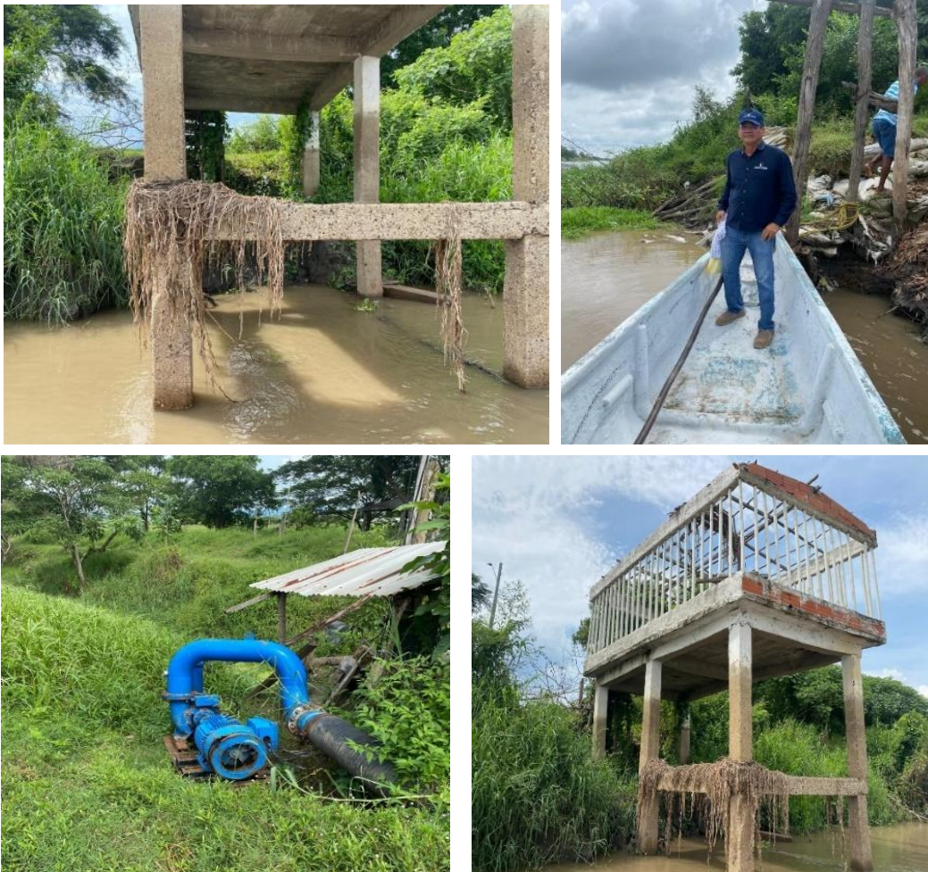
Fotografía 1. Inspección ocular y de seguimiento al canal del dique
