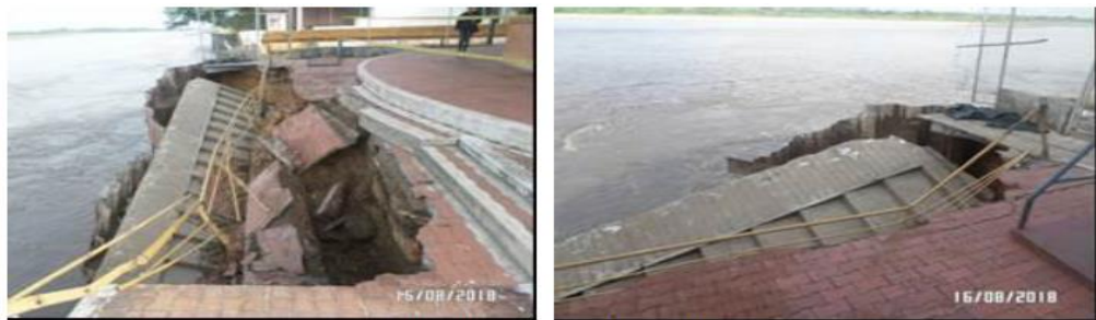
Zona de colapso de escales y andenes.
