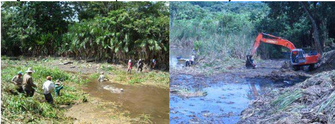
Fotografía 28. Actividades de recuperación de conectividad manual y mecánica.
