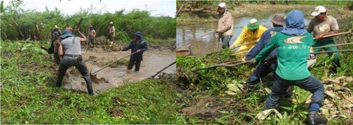
Fotografía 13. Repique del tapón en la orilla.
