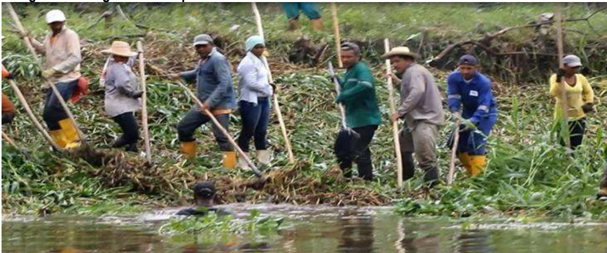
Fotografía 12. Enganche del tapón hacia la orilla.
